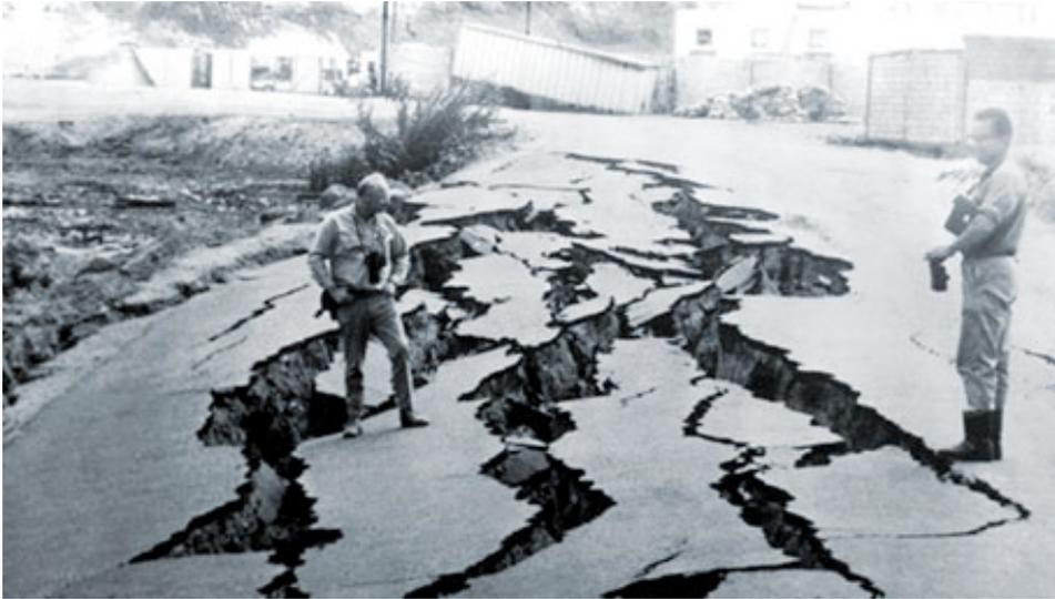
Abbildung 3.3.: Aufgerissene Strasse nach einem starken Erdbeben in Kalifornien. (USGS, 2006b)
